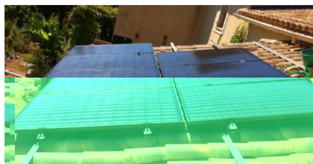
Figure 9 : Installation sur système de surimposition
